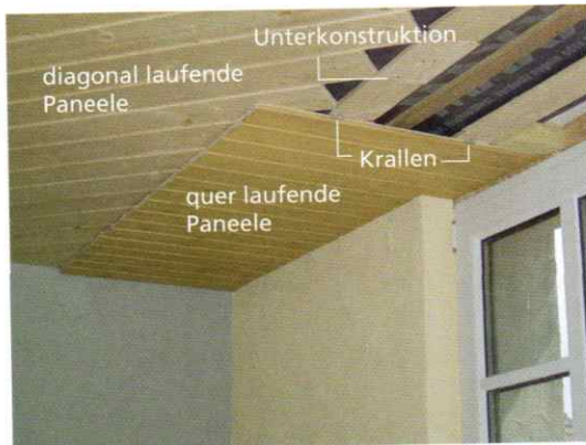
1 Unterkonstruktion von Deckenpaneelen
