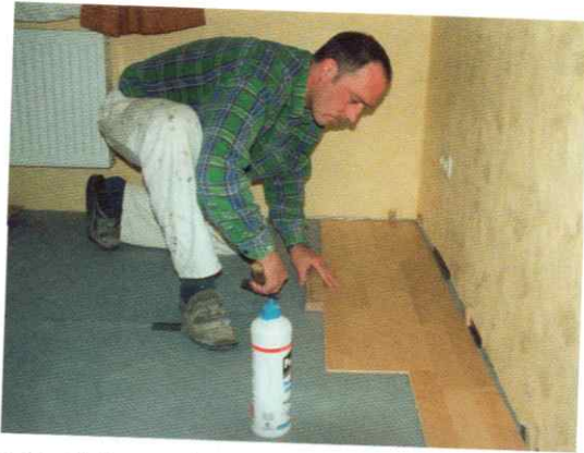
1 Der Untergrund muss wasserabweisende und schalldämmende Eigenschaften besitzen.
